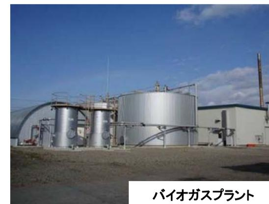
・本格焼酎製造工程におけるもろみ蒸留廃液(焼酎粕)をメタン発酵プロセスによりバイオガス化し、蒸気ボイラで熱回収を行った後、焼酎製造工程で使用する冷温熱源とする。工場は昼間のみの稼動で夜間の熱需要が無いため、蒸気駆動式吸収冷凍機により、24時間安定して需要のある発酵工程の冷却水の冷熱需要の全量をまかなう。さらにここで余剰となる熱は温水として蓄熱し、昼間に焼酎蒸留などの工程で使用する蒸気ボイラの顕熱源として使用。
