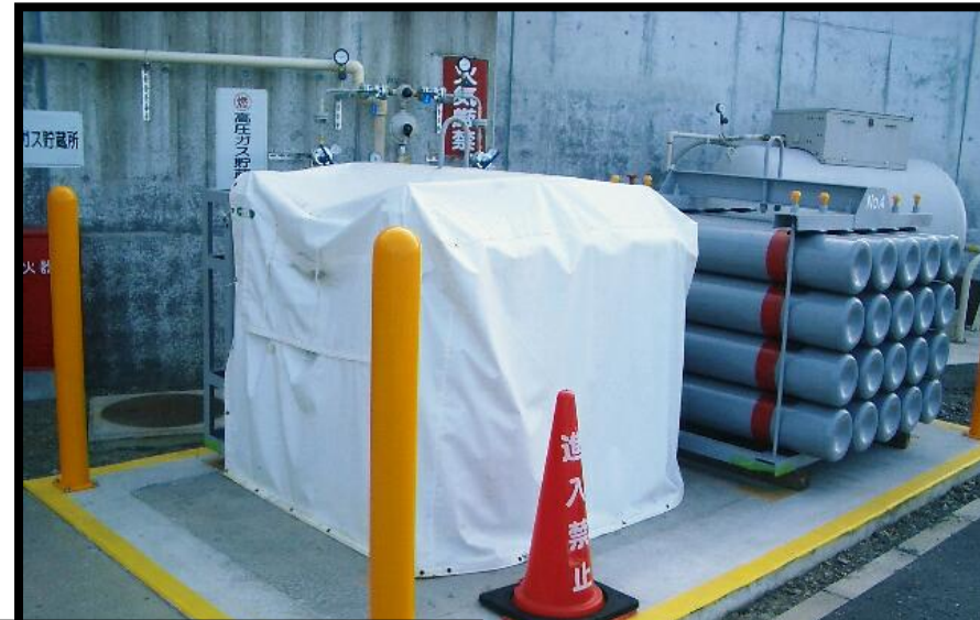
カードル設置状況
