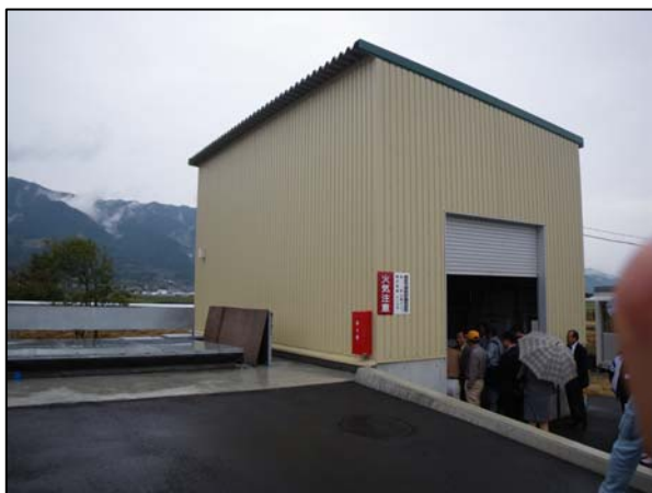
木質ボイラ用建屋
