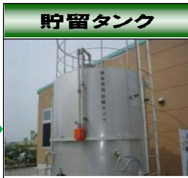
・貯蔵(廃油)タンク 4,000ℓ
