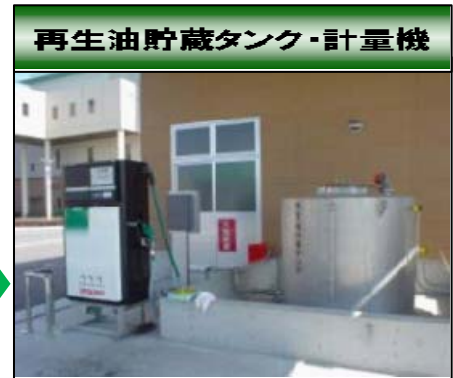
・貯留(BDF)タンク 2,000ℓ ・給油装置 一式
