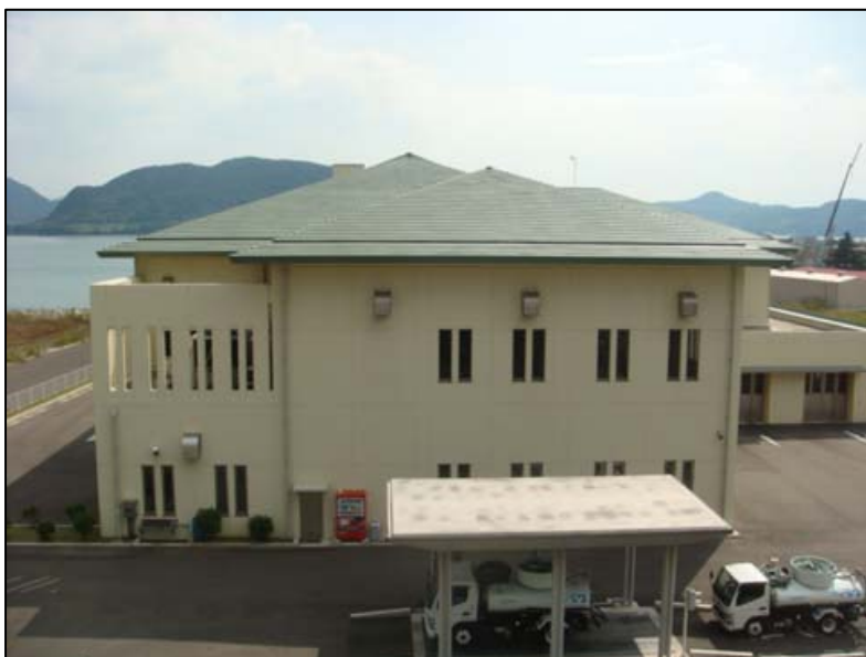
計量所と施設
