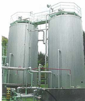
原液貯留設備
