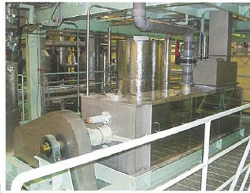
固液分離設備
