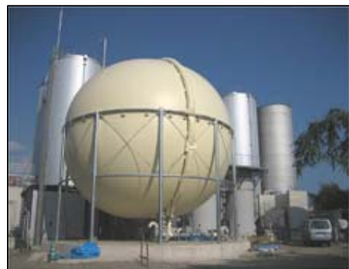
メタンガス貯蔵バルーン
