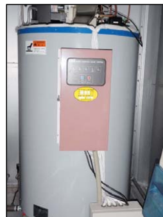
メタンガスボイラー
