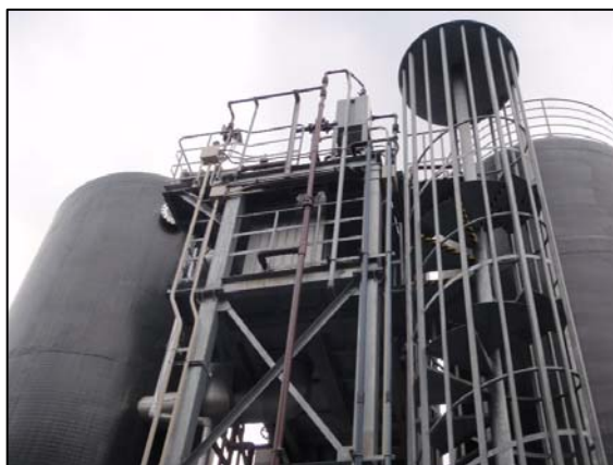
膜型メタン発酵槽
