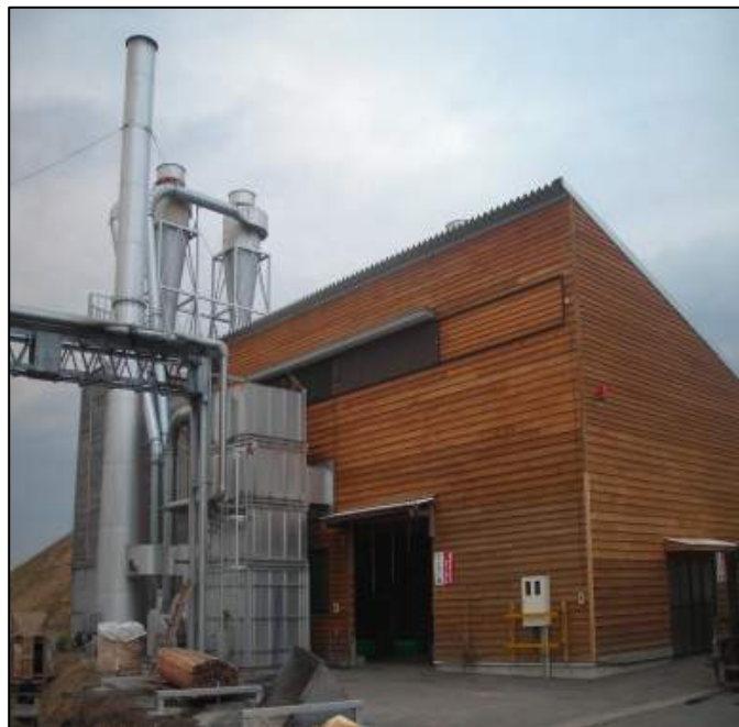
ボイラー棟全景
