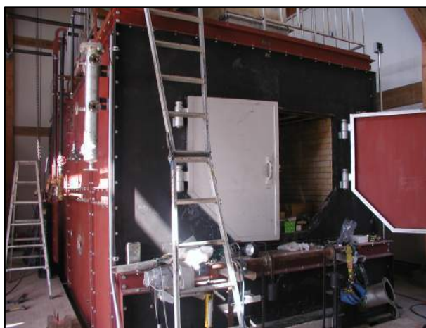
ボイラー本体
