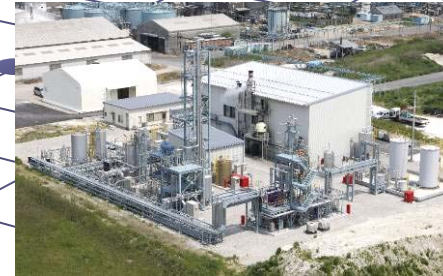
バイオエタノール製造
