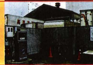
東京・平和島に設置されたメタノールスタンド
