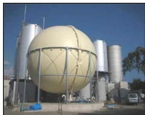
メタンガス貯蔵バルーン
