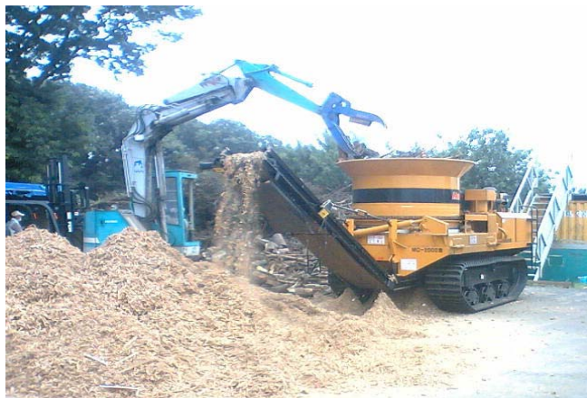
バイオマスチップ化設備
