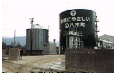
○メタン発酵施設(南丹市)
