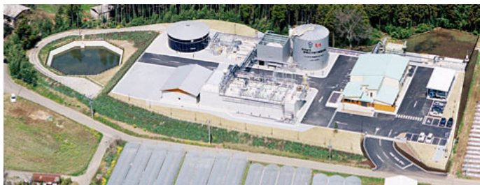
○日田市バイオマス資源化センター
