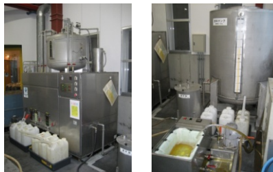
○バイオディーゼルの燃料製造施設(東近江市)
