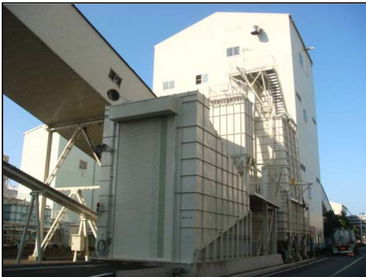
バイオマス受払設備(木質チップ)
