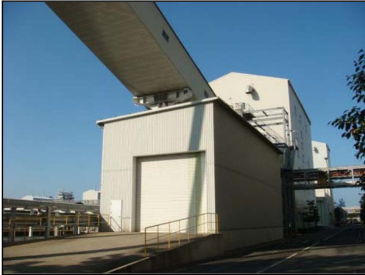
バイオマス受払設備(バイオソリッド)
