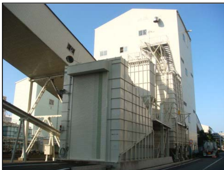
バイオマス受払設備(木質チップ)
