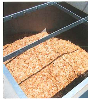
木質チップ投入設備
