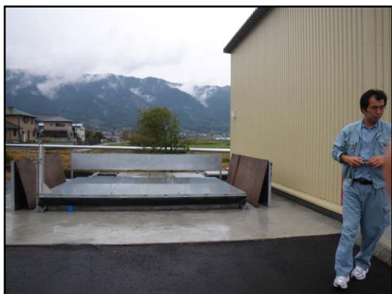
木質チップ投入口
