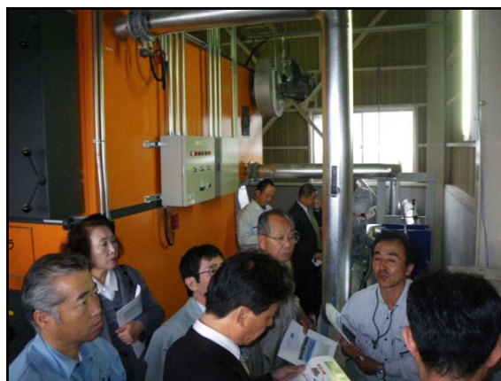
木質ボイラの様子
