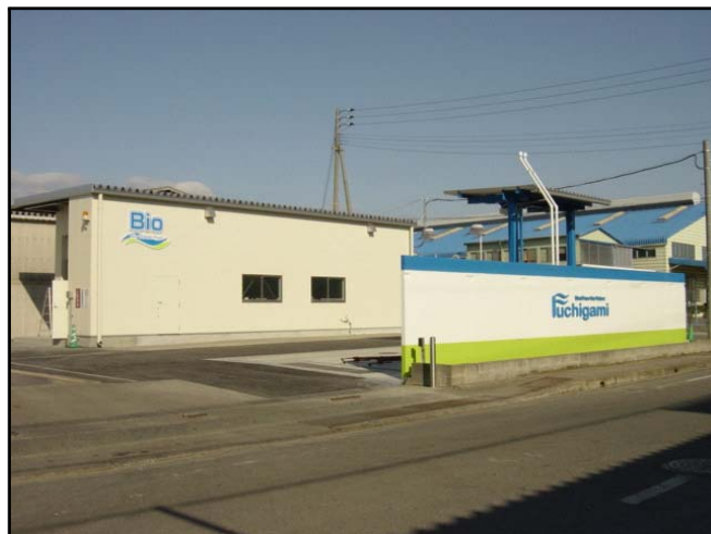
バイオディーゼル燃料製造工場全景
