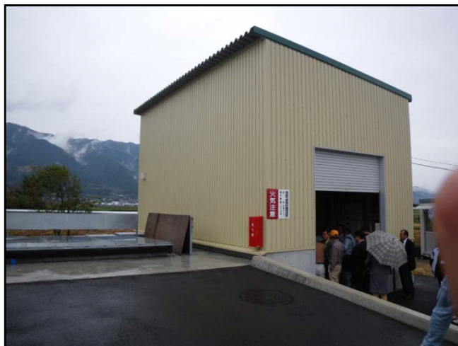
木質ボイラ用建屋
