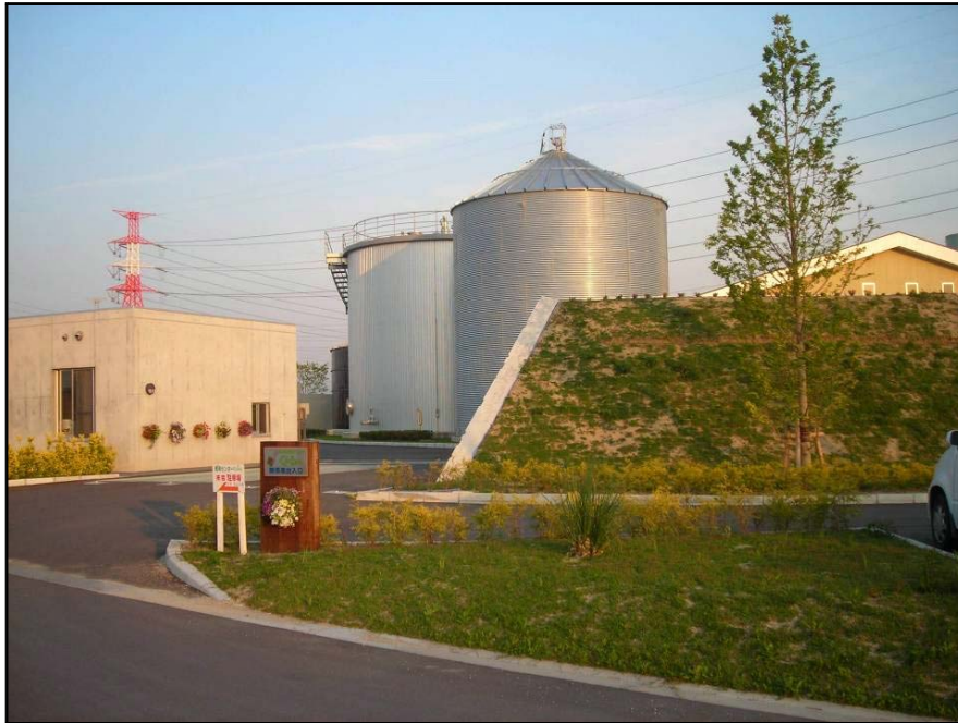
おおき循環センター全景
