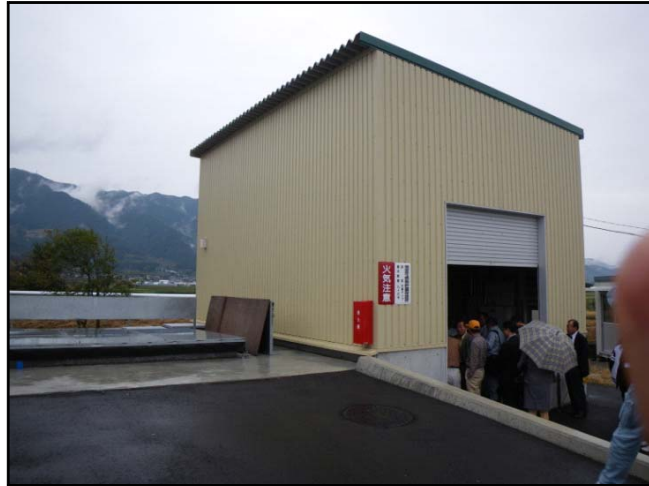
木質ボイラ用建屋
