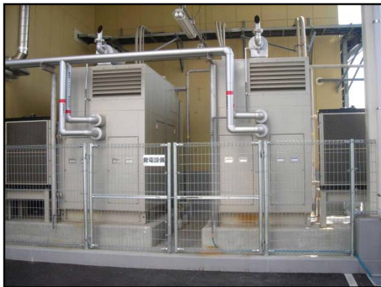
バイオガス発電機
