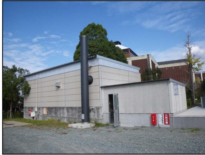
ボイラの建屋
