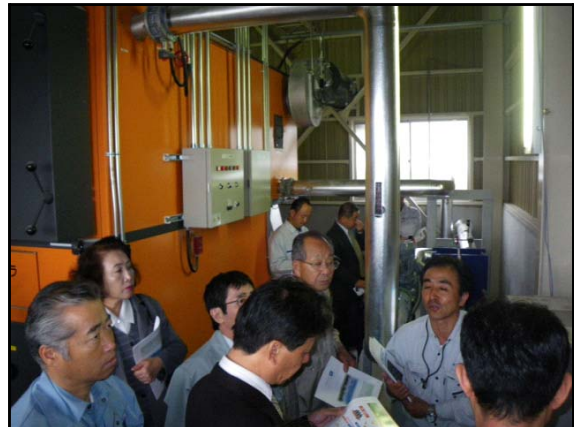
木質ボイラの様子
