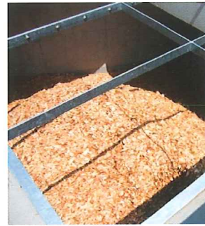
木質チップ投入設備
