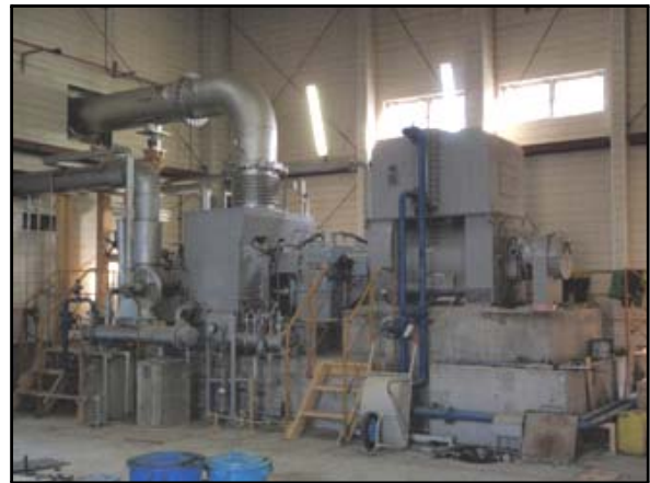
蒸気タービンと発電機(1200kW)
