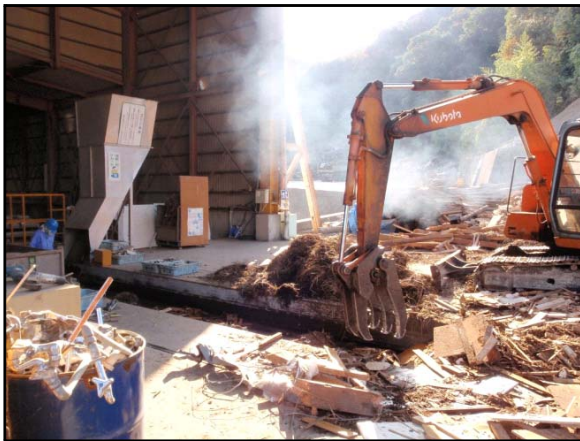
廃材解体分別作業
