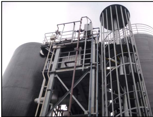
膜型メタン発酵槽
