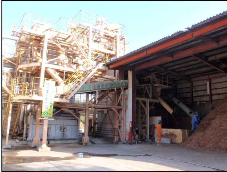
ボイラーと燃料投入口
