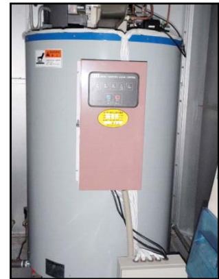
メタンガスボイラー
