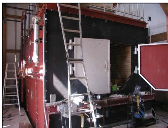
ボイラー本体
